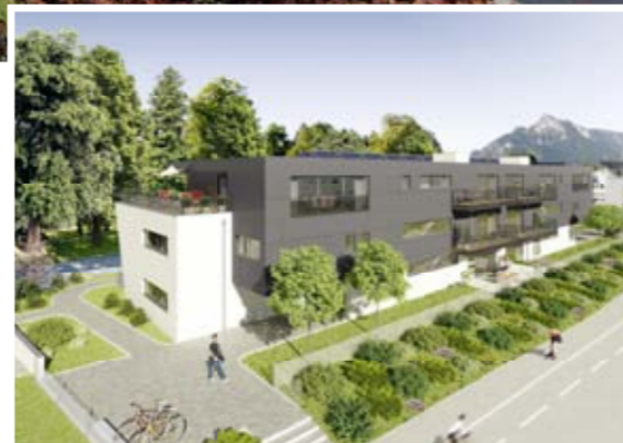
Aktuelles Bauprojekt in der Dr.-Adolf-Altmann-Straße im Nonntal: Es sind noch Wohnungen frei. Geplante Übergabe im Dezember.
